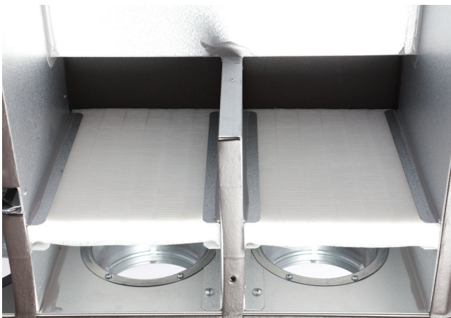
Filtros ISO ePM1 posicionados dentro do recuperador de calor.
