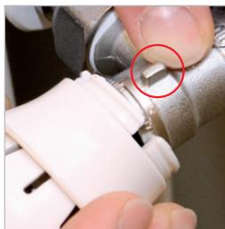
Emboitez la tête sur le robinet en alignant un des ergots dans l'encoche du robinet
