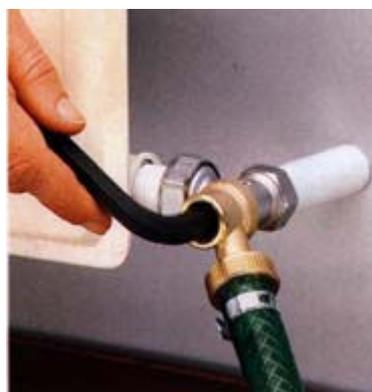
El retorno a las condiciones iniciales se efectúa muy simplemente volviendo a cerrar la montura, extrayendo el racor R700, reabriendo el obturador hasta el tope de la prerregulación. El tapón completa la operación.
