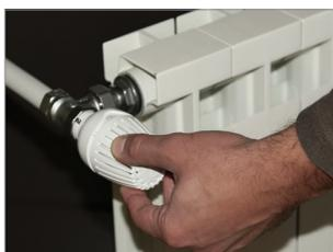
**3)** Der Thermostatkopf ist damit am Ventil befestigt und kann durch Drehen des Handrads auf die gewünschte Position eingestellt werden.
