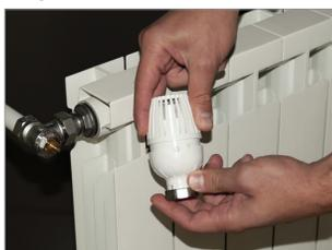
**1)** Thermostat vollständig öffnen; dies erfolgt durch Drehung in Stellung ⚙.
