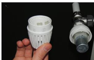
**3b)** Zur **Verriegelung** des Einstellbereichs einen Begrenzer rechts der Markierung anbringen, die der gewünschten Maximalöffnung entspricht. Einen zweiten Begrenzer links der Markierung anbringen, die der gewünschten Mindestöffnung entspricht. Auf diese Weise wird verhindert, dass der Thermostatkopf geöffnet oder geschlossen wird.
