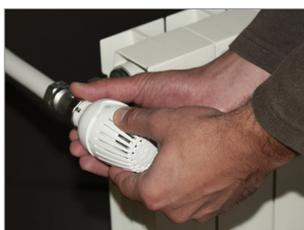
**2)** Thermostatkopf auf das Sechseck des Ventilgehäuses aufsetzen und mit dem Haltering festschrauben.
